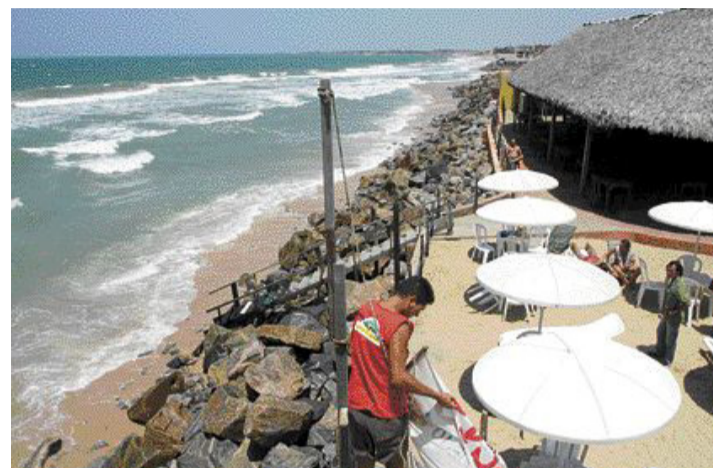
A erosão nas praias do litoral leste
